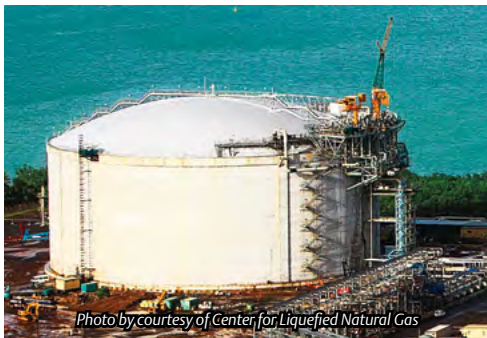
1.4: Cryogenic tank storing LNG at -162^{\circ}\text{C} .
