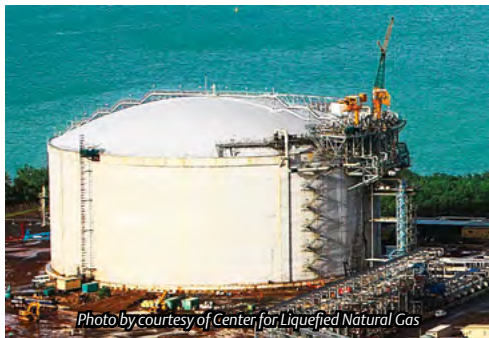
1.4: Cryogenic tank storing LNG at -162^{\circ}\text{C} .
